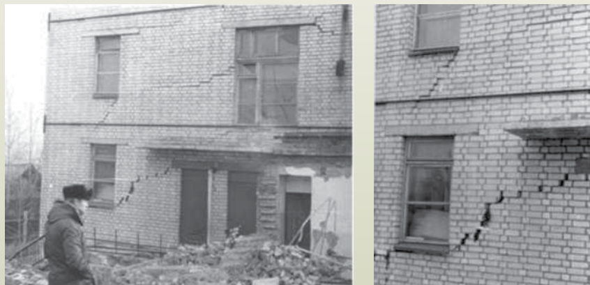
Рис 1. Фото развития аварийной ситуации для здания детского сада (г. Чита), возникшей в результате оттаивания линзы многолетней мерзлоты. Типичный дом с несущими стенами.
